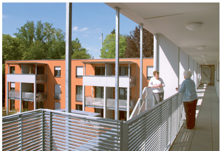
Modellvorhaben WAL: Die großzügigen Laubengänge sind attraktiver Treffpunkt für die Bewohner in der neuen Wohnanlage in Bamberg-Gaustadt. Sämtliche Wohnungen werden damit barrierefrei erschlossen. Foto: Joseph-Stiftung Bamberg
